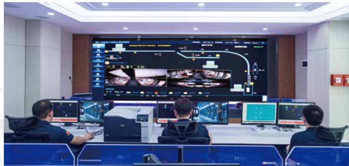
空轨运营控制中心
